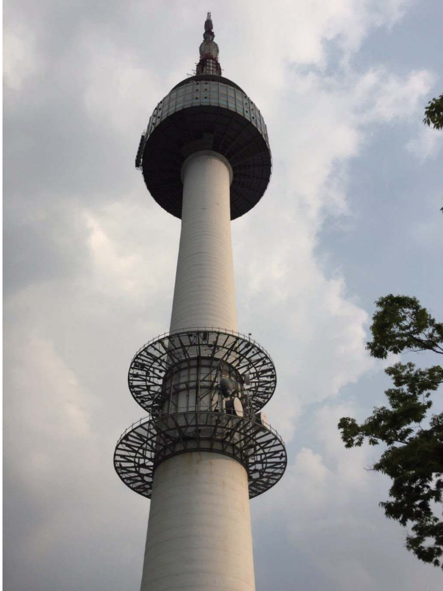
写真：ソウルタワー
