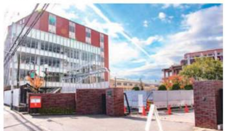
正門横に工事車両用のゲートが設置されました
