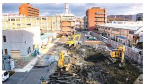
B号館跡地では大型重機が次々に廻り進めています
