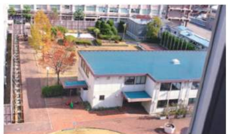
R号館を含む中庭周辺は仮囲いで覆われました
