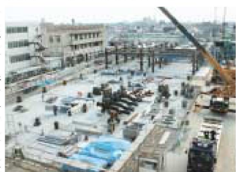
急ピッチで進む建設工事
