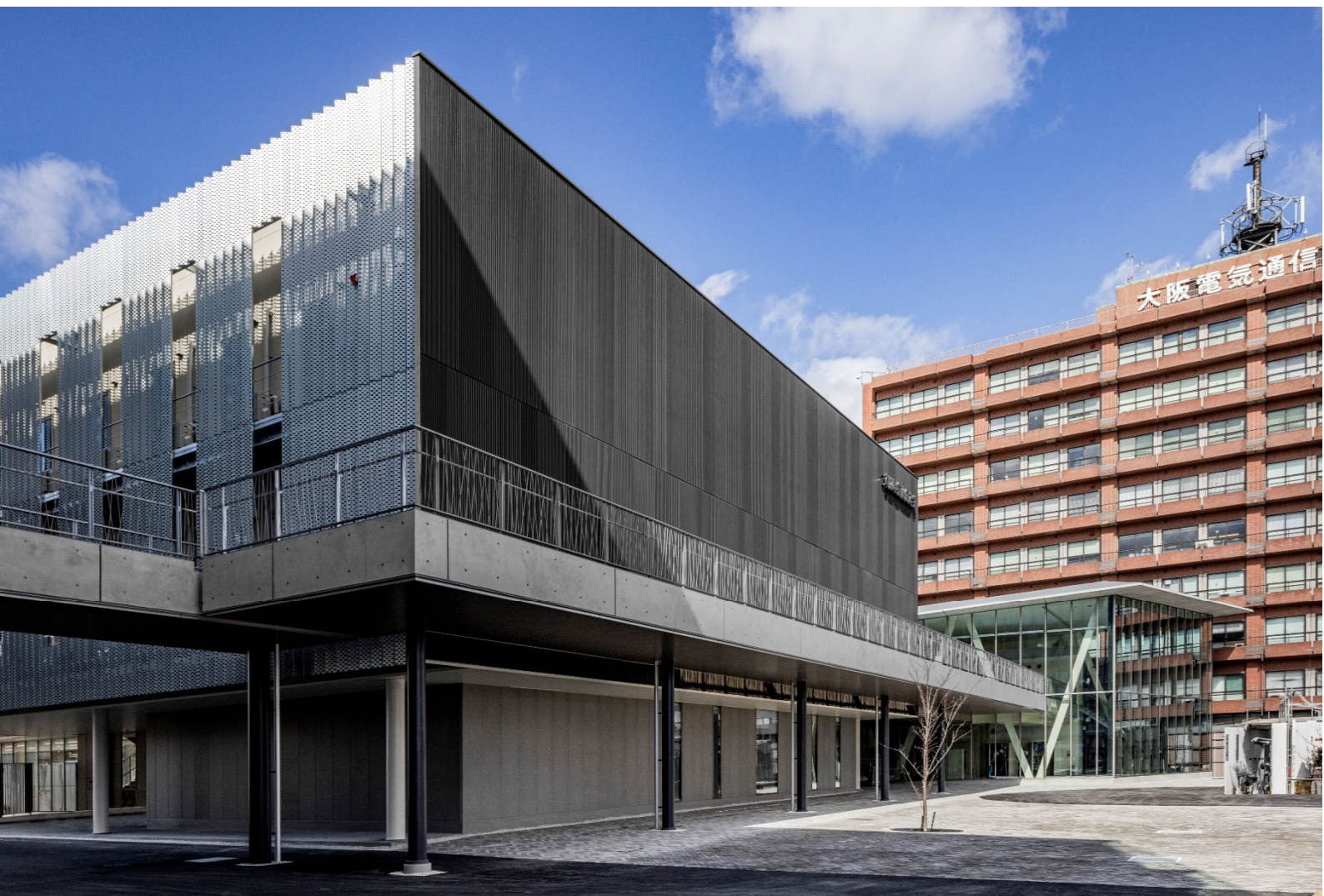
新棟と旧M号館（2023年解体済）
